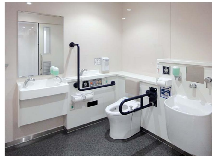
便器や手すりの前出を抑えたコンパクト多機能トイレパックを採用。車いす使用者のほかオストメイトの方にも配慮し、オストメイト対応トイレパックも備えている。
