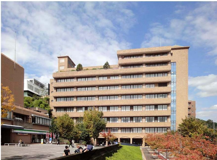
5号館は大学創立30周年記念事業の一つとして、1996年に情報教育の拠点として建設された。地下1階、地上8階の9階建てで、主に教室で構成されている。
